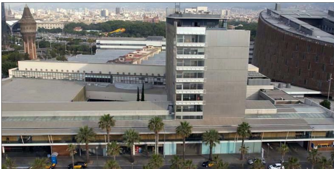
Figura 4. Visió actual del complex de l'Hospital del Mar. En primera línia es pot veure un edifici alt, que va ser la seu de l'Institut Neurològic i que ara són plantes d'hospitalització. A la dreta s'observa l'edifici del Parc de Recerca Biomèdica de Barcelona (PRBB) on s'allotja l'IMIM. En la zona central de la imatge s'observa el que queda dels antics pavellons originals de l'Hospital. A la part de darrera es troba l'edifici del Campus del Mar, on s'imparteixen els estudis de Medicina (UAB-UPF), Biologia humana (UPF), Infermeria (PSMAR-UPF), Fisioteràpia (UAB) i Enginyeria biomèdica (UPF).
